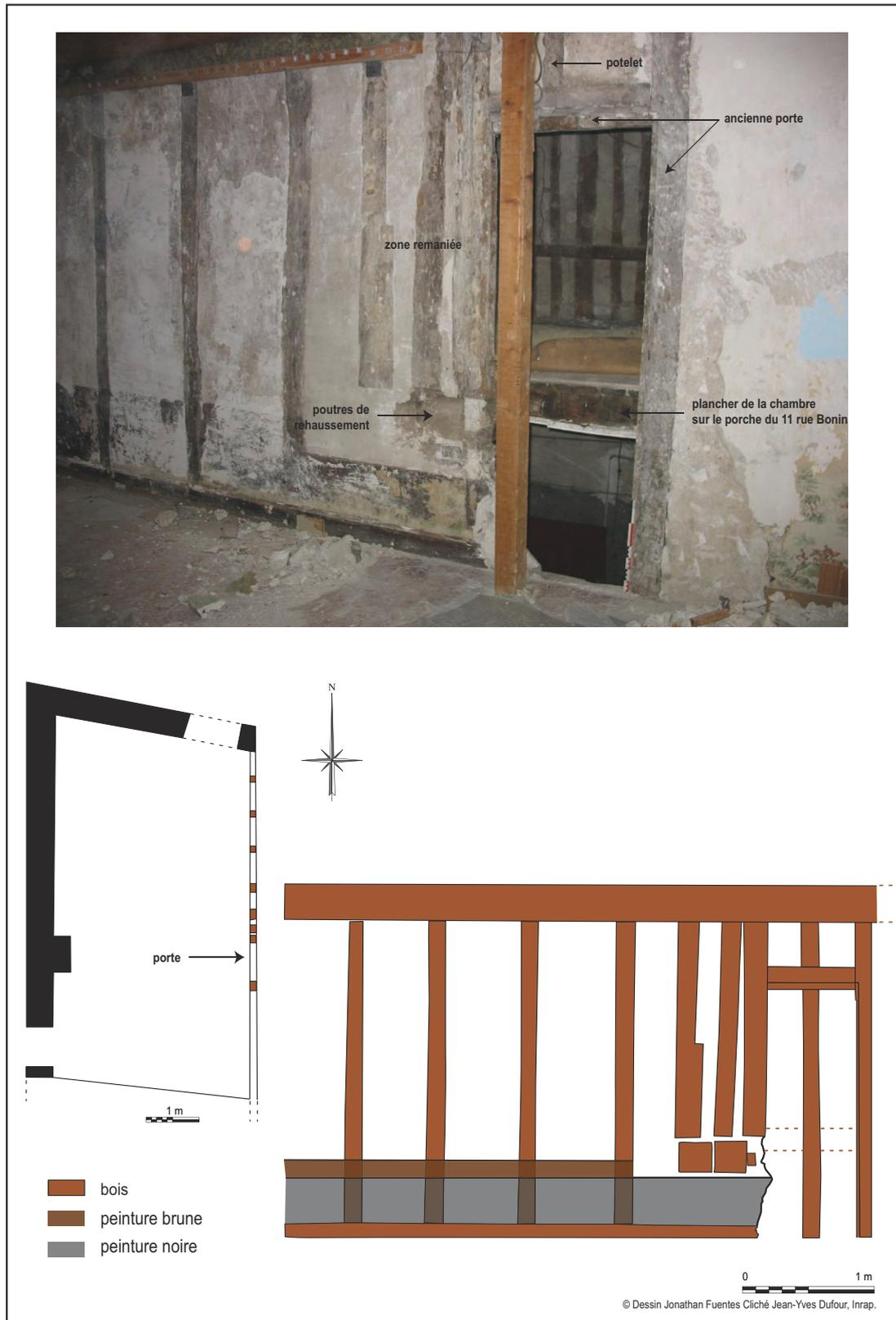
Fig. 9 : La chambre à l'étage du 13 de la rue Bonin. Vue et relevé du pan du bois signalant une ancienne porte
