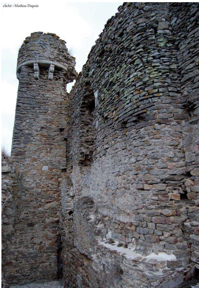
**Fig. 9** : Vue de la paroi extérieure du mur ouest de la pièce 14 depuis le sud-ouest, on remarque l'angle arrondi sur lequel est appuyé le mur ouest de la pièce 11 ainsi que les relations stratigraphiques avec la tour III (Mathias Dupuis).
